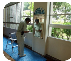
廊下壁面の塗装
